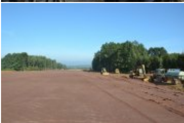
Budowa drogi ekspresowej S3
