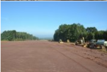
Budowa drogi ekspresowej S3
