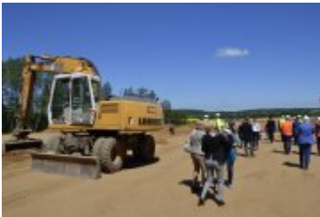
Budowa drogi ekspresowej S3
