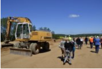
Budowa drogi ekspresowej S3
