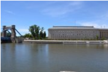
Budynek Dolnośląskiego Urzędu Wojewódzkiego we Wrocławiu
