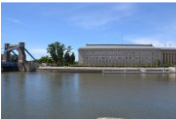
Budynek Dolnośląskiego Urzędu Wojewódzkiego we Wrocławiu
