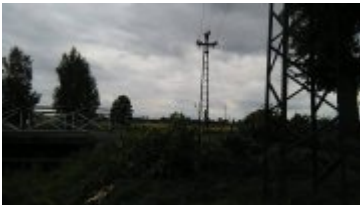
Skutki frontu burzowego
