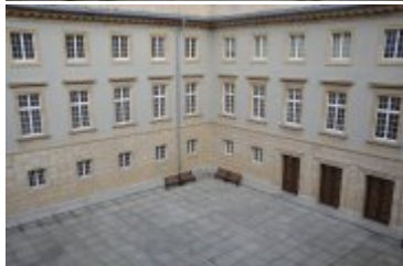
Atrium w budynku Dolnośląskiego Urzędu Wojewódzkiego we Wrocławiu
