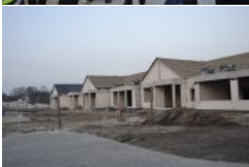
Budowa oddziału szkolnego
