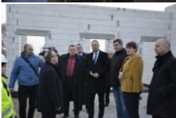
Wojewoda ogląda postępy prac w budowie szkoły
