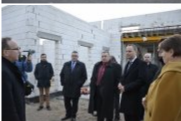
Wizytacja budowy szkoły
