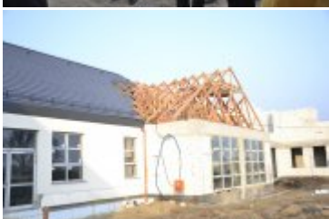
Budowa Zespołu Szkolno-Przedszkolnego w Dobrzykowicach
