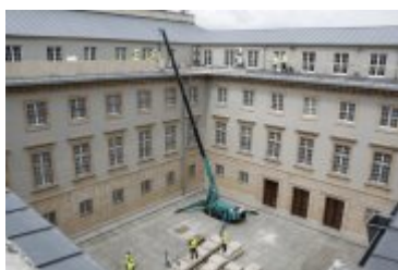
Prace na dziedzińcu wewnętrznym Dolnośląskiego Urzędu Wojewódzkiego
