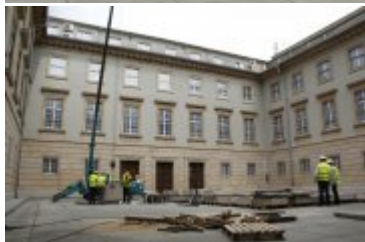
Prace na dziedzińcu wewnętrznym Dolnośląskiego Urzędu Wojewódzkiego
