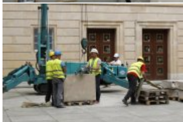
Prace na dziedzińcu wewnętrznym Dolnośląskiego Urzędu Wojewódzkiego
