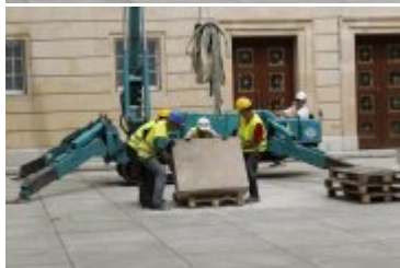
Prace na dziedzińcu wewnętrznym Dolnośląskiego Urzędu Wojewódzkiego
