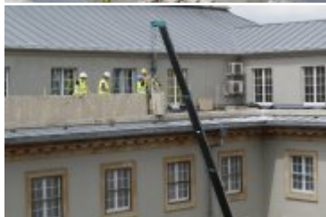
Prace na dziedzińcu wewnętrznym Dolnośląskiego Urzędu Wojewódzkiego
