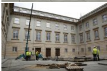
Prace na dziedzińcu wewnętrznym Dolnośląskiego Urzędu Wojewódzkiego
