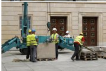
Prace na dziedzińcu wewnętrznym Dolnośląskiego Urzędu Wojewódzkiego
