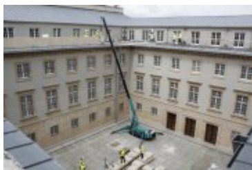
Prace na dziedzińcu wewnętrznym Dolnośląskiego Urzędu Wojewódzkiego
