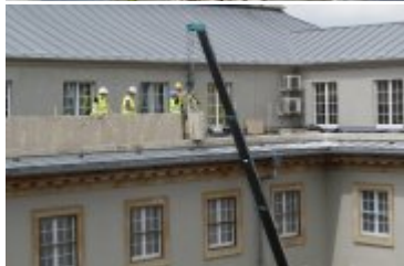
Prace na dziedzińcu wewnętrznym Dolnośląskiego Urzędu Wojewódzkiego
