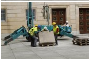
Prace na dziedzińcu wewnętrznym Dolnośląskiego Urzędu Wojewódzkiego
