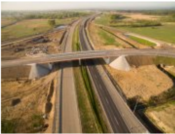
Widok na obiekt wd-38a km 67436 6; fot. GDDKiA_Wrocław
