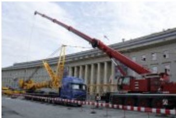
Przebudowa dziedzińca wewnętrznego DUW
