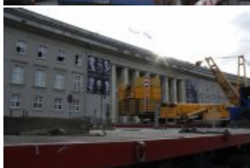
Przygotowania do kolejnego etapu przebudowy
