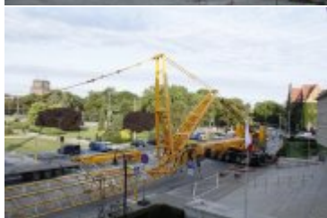
Przygotowania do kolejnego etapu przebudowy
