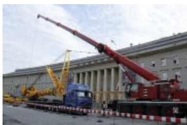
Przebudowa dziedzińca wewnętrznego DUW
