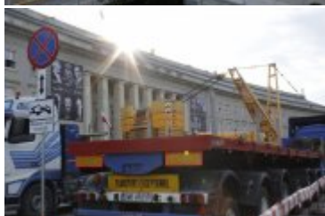
Przygotowania do kolejnego etapu przebudowy
