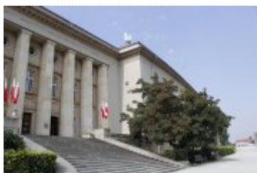
Dolnośląski Urząd Wojewódzki we Wrocławiu - wejście od strony Odry
