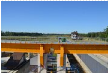
Budowa stopnia wodnego w Malczycach
