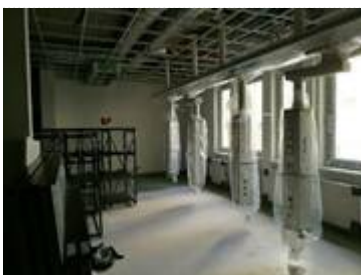
Budowa Zintegrowanego Bloku Operacyjnego w Szpitalu Wojskowym
