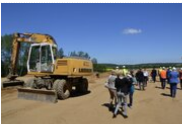
Budowa drogi ekspresowej S3
