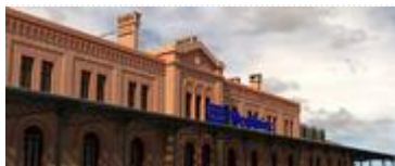
Niebawem ruszy przebudowa dworca kolejowego w Węglińcu
